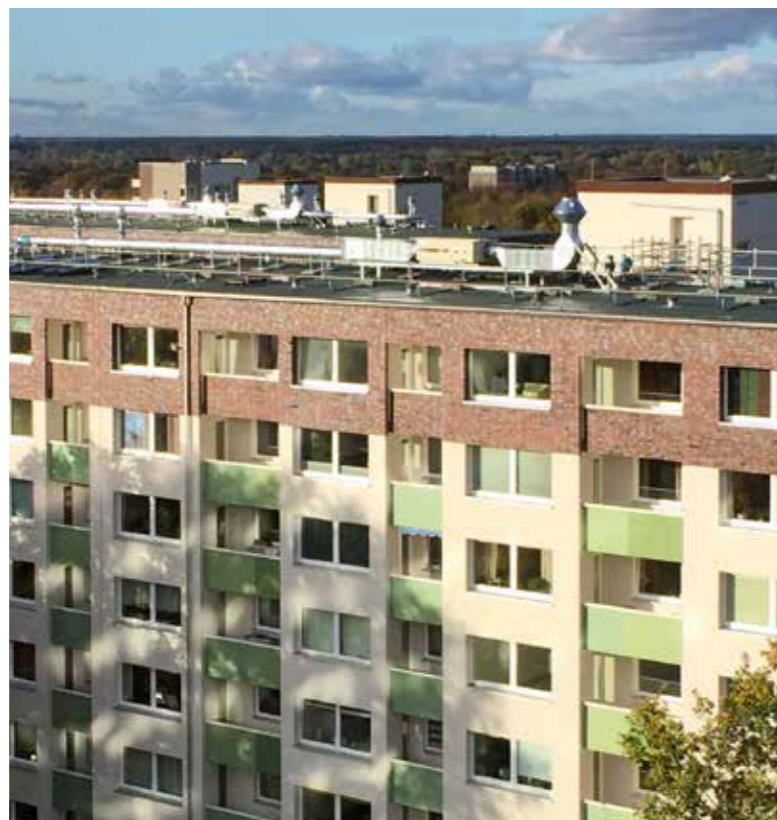
Energie vom Dach Die prämierte Quartiersentwicklung des BVE am Heidrehmen umfasst auch Solarthermie.
