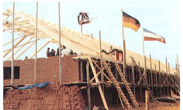
1965: Richtfeier im Moorweg
