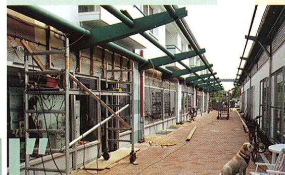
1997: Das neue „Walddörfer Rondell“ im Bau
